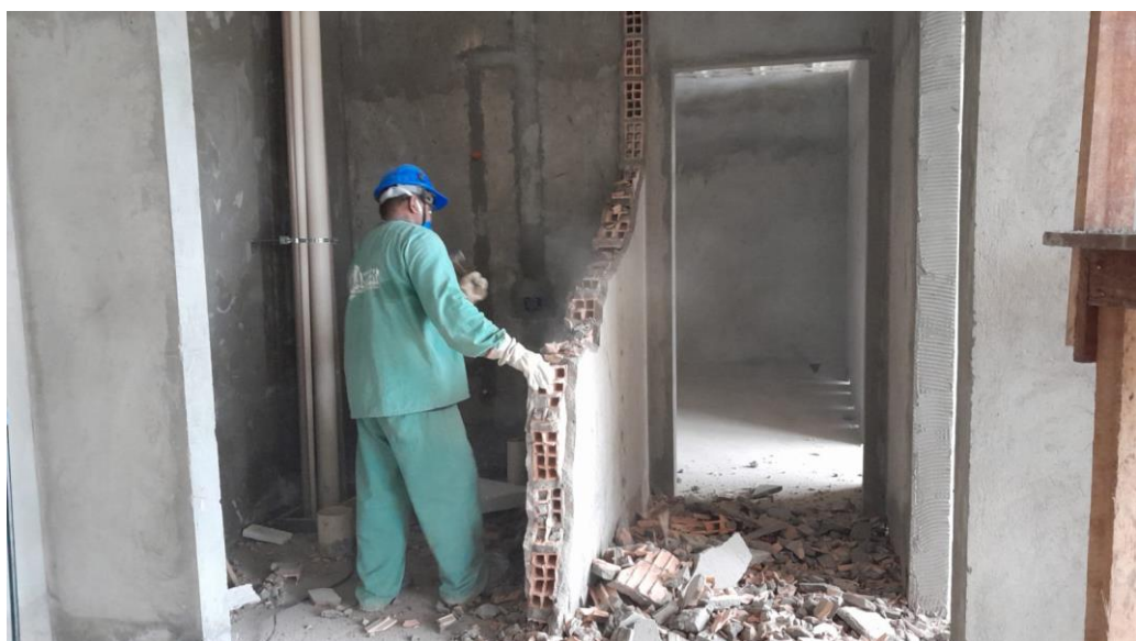
13.18 Demolição de alvenaria
