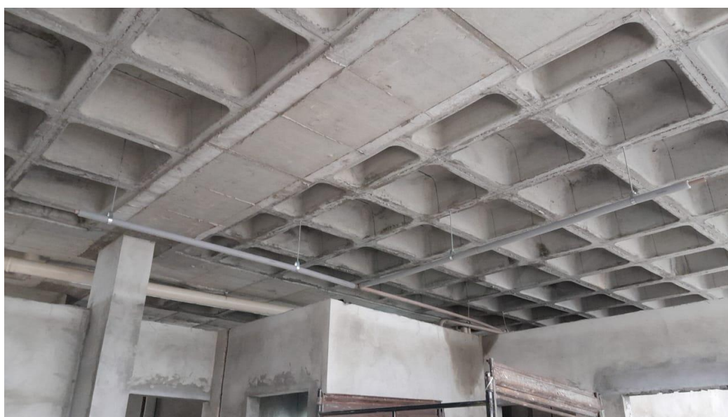
13.12 Instalação elétrica do piso
