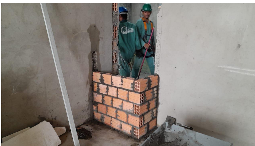
13.9 Execução de alvenaria
